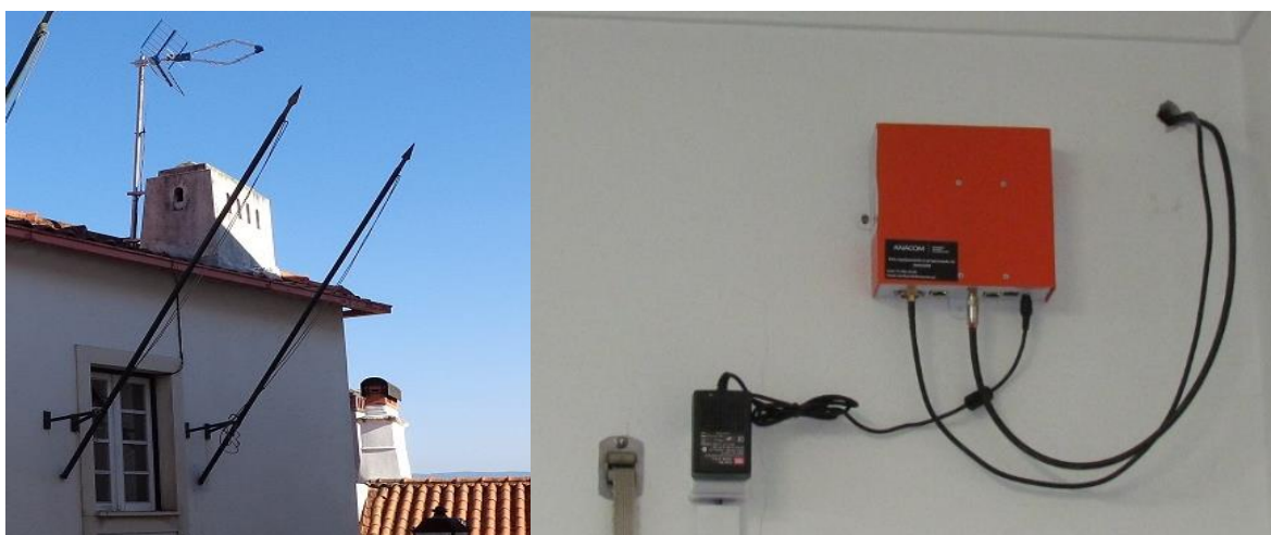
Figura 3 – Instalação de receção das sondas TDT
