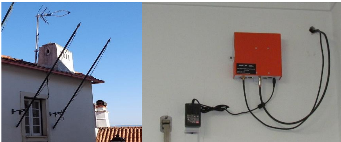
Figura 3 – Instalação de receção das sondas TDT
