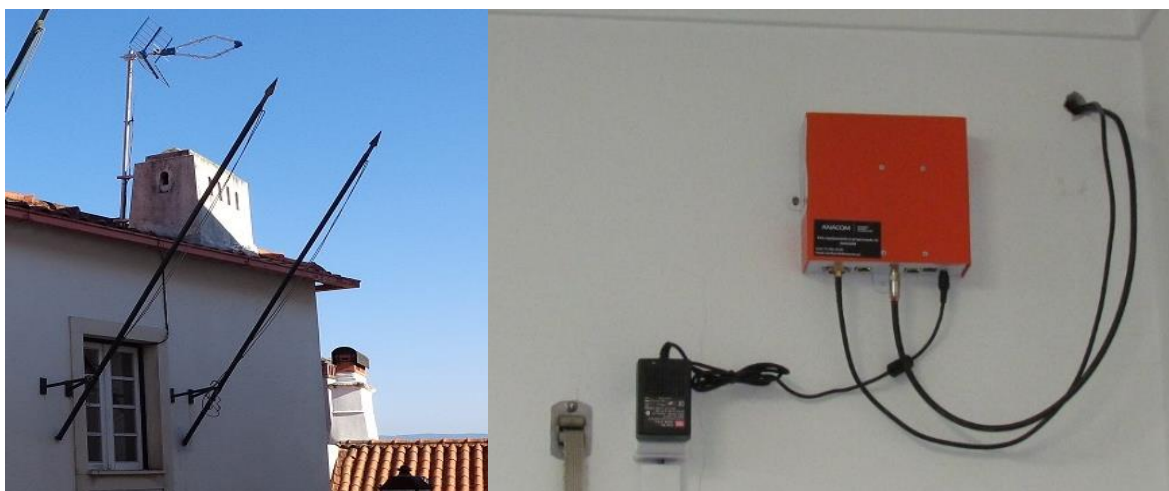
Figura 1 – Instalação de receção das sondas TDT
